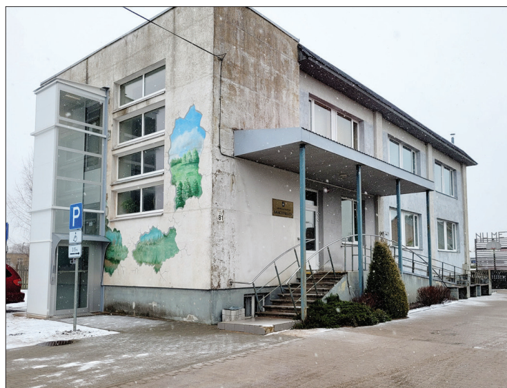
Pacēlājs nokļūšanai doktorāta 2. stāvā izbūvēts ēkas galā.
