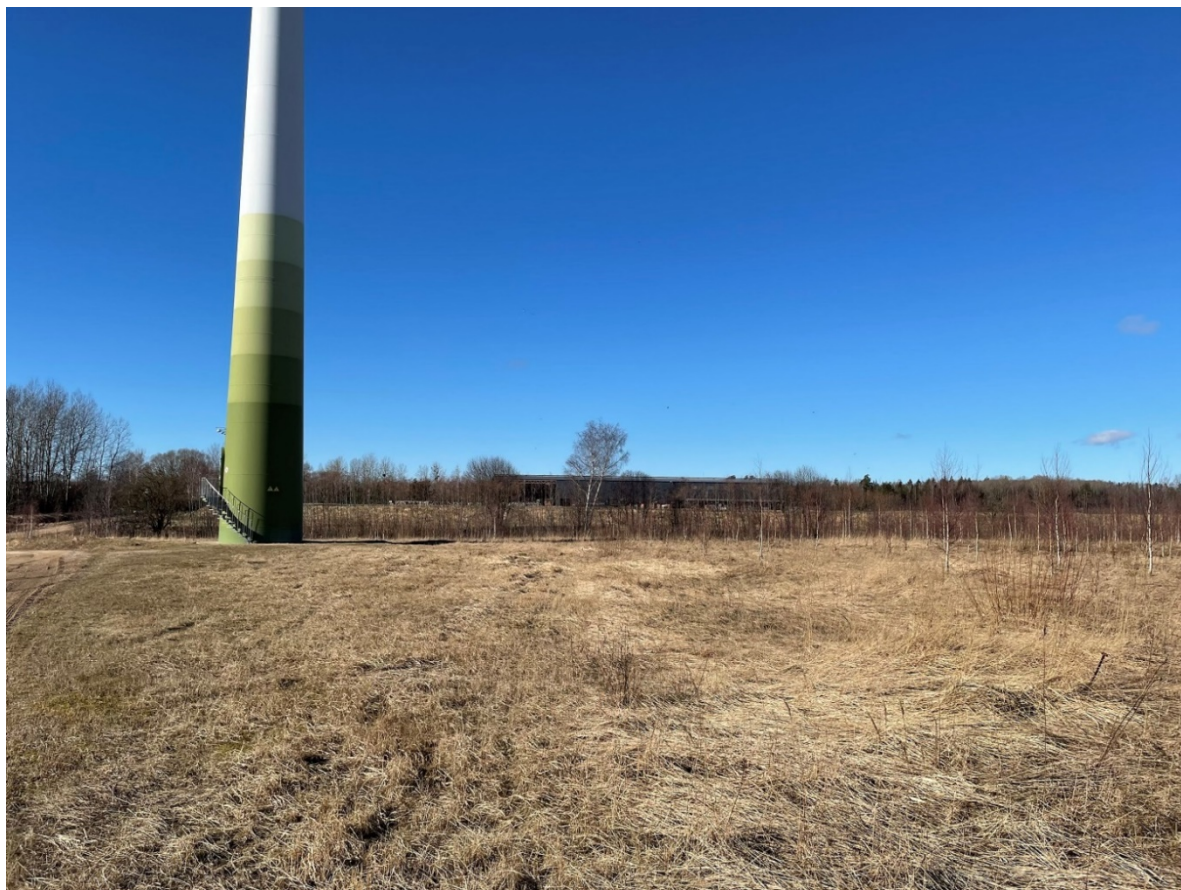
2.12.3 attēls. Skats uz plānoto darbības vietu no austrumu puses
