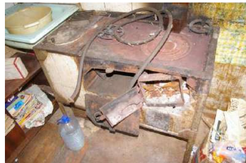
Būve ar kadastra apzīmējumu 6442 001 0030 001, dzīvoklis Nr.2, telpa Nr.3, plīts
