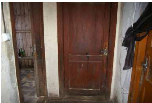
Dzīvojamā ēka ar kadastra apzīmējumu 6452 012 0188 001, koplietošanas telpa
