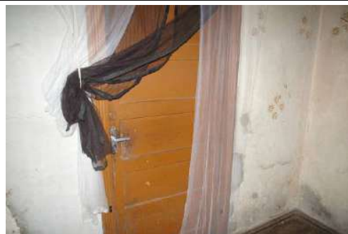
Dzīvojamā ēka ar kadastra apzīmējumu 6452 012 0188 001, koplietošanas telpa
