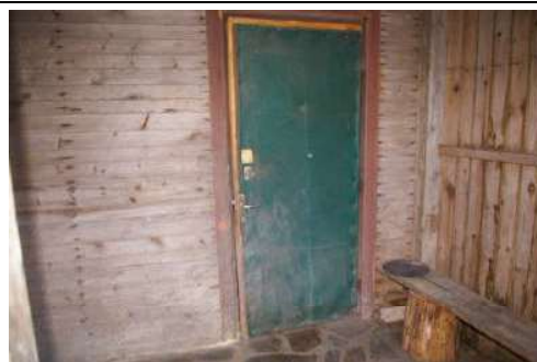
Dzīvojamā ēka ar kadastra apzīmējumu 6452 012 0188 001, koplietošanas telpa
