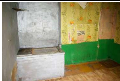
Būve ar kadastra apzīmējumu 6468 003 0034 042, dzīvoklis Nr.2, telpa Nr.1
