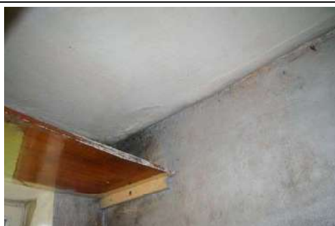
Būve ar kadastra apzīmējumu 6468 003 0034 042, dzīvoklis Nr.2, telpa Nr.2
