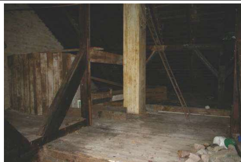
Skolas ēka ar kadastra apzīmējumu 6456 001 0224 001, bēniņi
