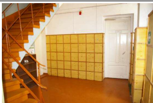
Skolas ēka ar kadastra apzīmējumu 6456 001 0224 001, 1.stāvs
