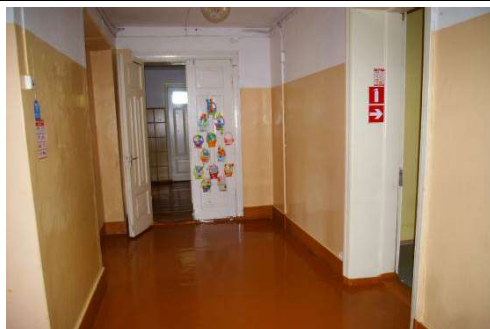
Skolas ēka ar kadastra apzīmējumu 6456 001 0224 001, 2.stāvs
