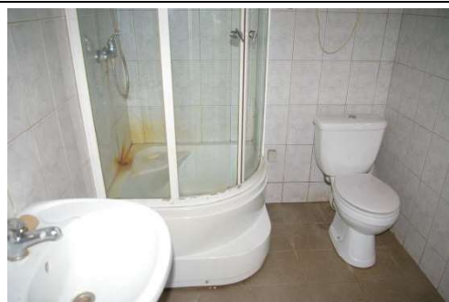
Skolas ēka ar kadastra apzīmējumu 6456 001 0224 001, 1.stāvs
