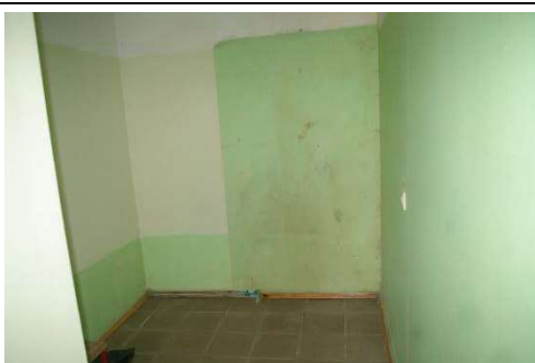
Skolas ēka ar kadastra apzīmējumu 6456 001 0224 001, 1.stāvs
