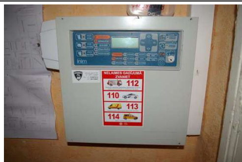
Skolas ēka ar kadastra apzīmējumu 6456 001 0224 001, 1.stāvs
