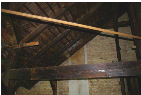
Skolas ēka ar kadastra apzīmējumu 6456 001 0224 001, bēniņi
