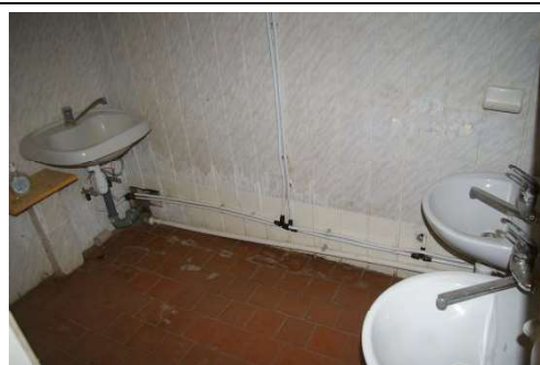
Skolas ēka ar kadastra apzīmējumu 6456 001 0224 001, 1.stāvs
