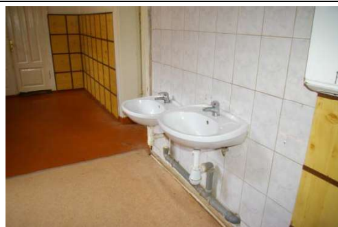
Skolas ēka ar kadastra apzīmējumu 6456 001 0224 001, 1.stāvs
