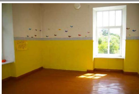
Skolas ēka ar kadastra apzīmējumu 6456 001 0224 001, 1.stāvs
