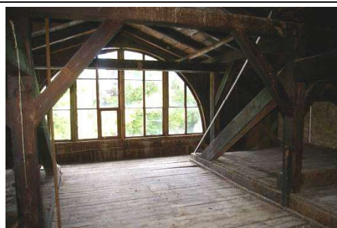
Skolas ēka ar kadastra apzīmējumu 6456 001 0224 001, bēniņi
