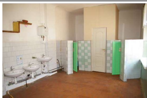
Skolas ēka ar kadastra apzīmējumu 6456 001 0224 001, 2.stāvs
