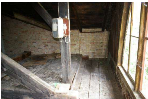
Skolas ēka ar kadastra apzīmējumu 6456 001 0224 001, bēniņi
