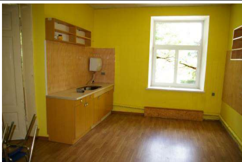
Skolas ēka ar kadastra apzīmējumu 6456 001 0224 001, 2.stāvs
