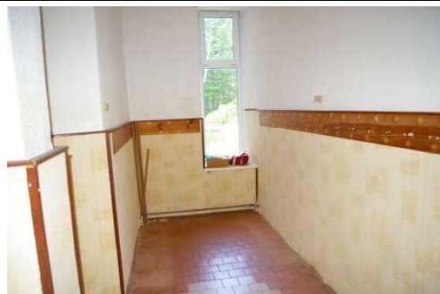
Skolas ēka ar kadastra apzīmējumu 6456 001 0224 001, 1.stāvs
