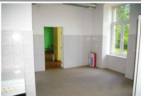
Skolas ēka ar kadastra apzīmējumu 6456 001 0224 001, 1.stāvs
