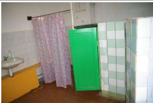
Skolas ēka ar kadastra apzīmējumu 6456 001 0224 001, 1.stāvs
