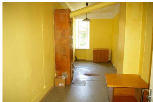
Skolas ēka ar kadastra apzīmējumu 6456 001 0224 001, 2.stāvs
