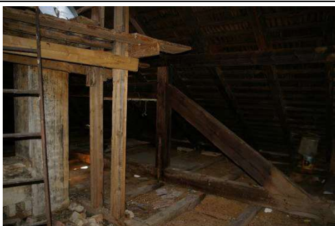
Skolas ēka ar kadastra apzīmējumu 6456 001 0224 001, bēniņi
