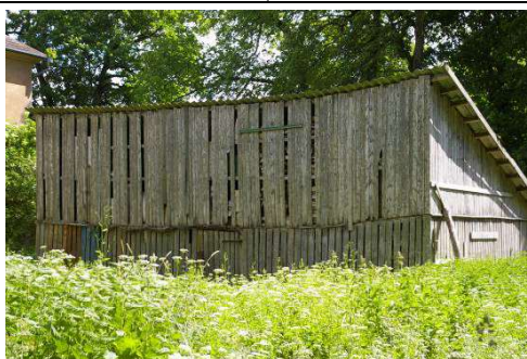
Šķūņa ēka ar kadastra apzīmējumu 6456 001 0224 002
