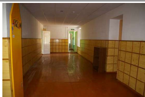
Skolas ēka ar kadastra apzīmējumu 6456 001 0224 001, 2.stāvs
