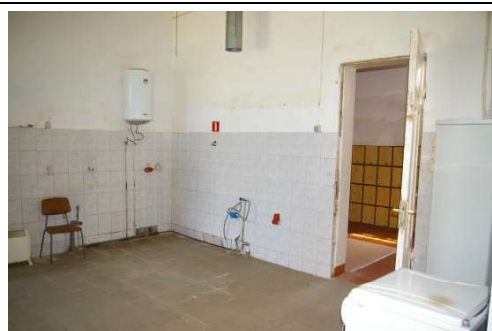
Skolas ēka ar kadastra apzīmējumu 6456 001 0224 001, 1.stāvs
