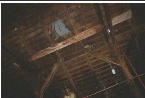
Skolas ēka ar kadastra apzīmējumu 6456 001 0224 001, bēniņi
