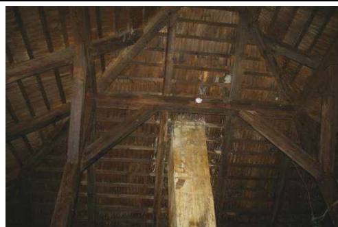
Skolas ēka ar kadastra apzīmējumu 6456 001 0224 001, bēniņi
