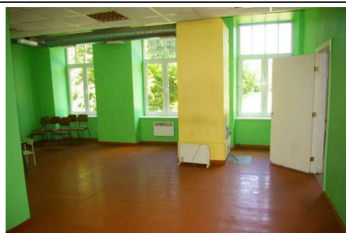
Skolas ēka ar kadastra apzīmējumu 6456 001 0224 001, 1.stāvs
