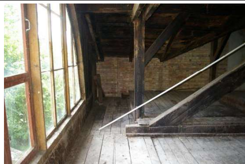
Skolas ēka ar kadastra apzīmējumu 6456 001 0224 001, bēniņi
