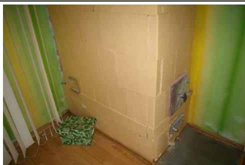
Skolas ēka ar kadastra apzīmējumu 6456 001 0224 001, 1.stāvs
