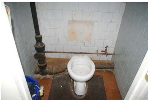
Skolas ēka ar kadastra apzīmējumu 6456 001 0224 001, 2.stāvs
