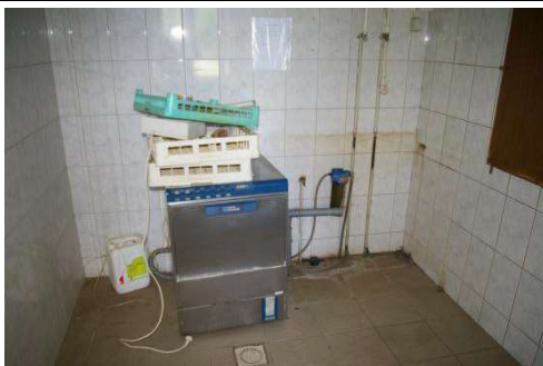
Skolas ēka ar kadastra apzīmējumu 6456 001 0224 001, 1.stāvs
