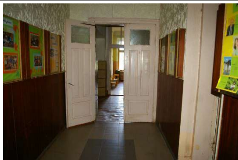
Skolas ēka ar kadastra apzīmējumu 6456 001 0224 001, 1.stāvs
