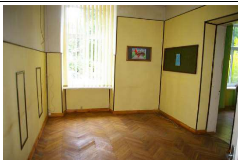
Skolas ēka ar kadastra apzīmējumu 6456 001 0224 001, 1.stāvs
