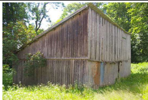
Šķūņa ēka ar kadastra apzīmējumu 6456 001 0224 002
