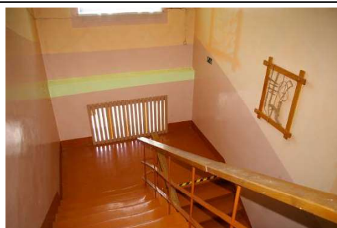
Skolas ēka ar kadastra apzīmējumu 6456 001 0224 001, 2.stāvs
