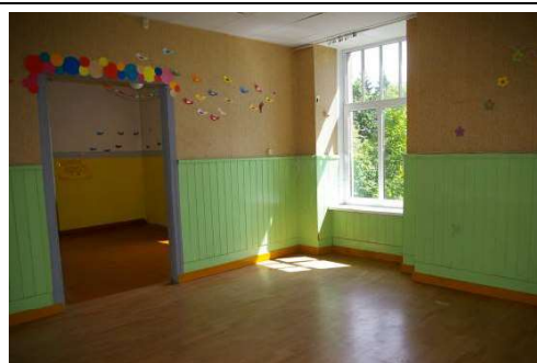
Skolas ēka ar kadastra apzīmējumu 6456 001 0224 001, 1.stāvs
