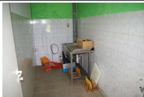
Skolas ēka ar kadastra apzīmējumu 6456 001 0224 001, 1.stāvs
