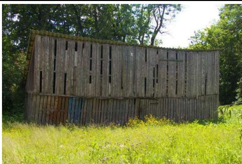
Šķūņa ēka ar kadastra apzīmējumu 6456 001 0224 002
