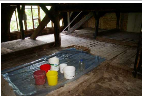
Skolas ēka ar kadastra apzīmējumu 6456 001 0224 001, bēniņi
