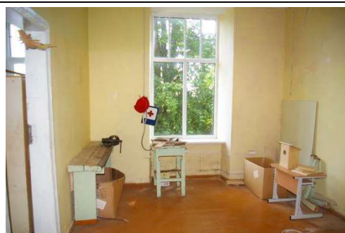
Skolas ēka ar kadastra apzīmējumu 6456 001 0224 001, 1.stāvs
