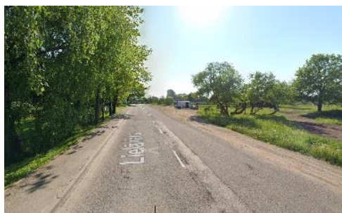
4-25. ATTĒLS. SKATS UZ LIELĀS IELAS POSMU STARP VENTSPILS UN BĀRTAS IELĀM
