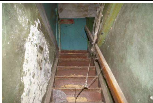
Būve ar kadastra apzīmējumu 6405 010 0158 002, koplietošanas telpa
