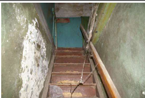
Būve ar kadastra apzīmējumu 6405 010 0158 002, koplietošanas telpa
