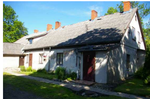
Būve ar kadastra apzīmējumu 6405 010 0192 001, kopskats no pagalma puses
