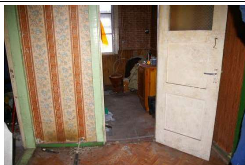
Būve (dzīvojamā ēka) ar kadastra apzīmējumu 6488 006 0037 007
