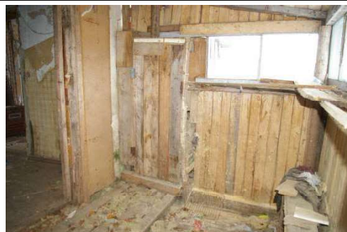
Būve (dzīvojamā ēka) ar kadastra apzīmējumu 6488 006 0037 007
