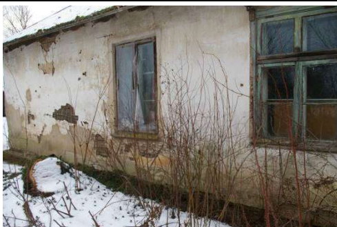
Būve (dzīvojamā ēka) ar kadastra apzīmējumu 6488 006 0037 007
