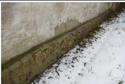
Būve (dzīvojamā ēka) ar kadastra apzīmējumu 6488 006 0037 007
