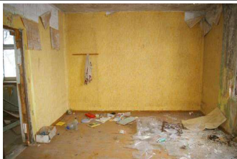
Būve (dzīvojamā ēka) ar kadastra apzīmējumu 6488 006 0037 007
