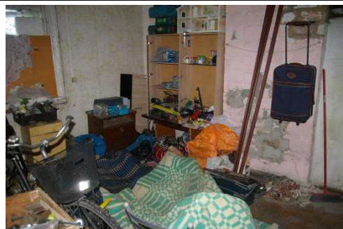
Būve (dzīvojamā ēka) ar kadastra apzīmējumu 6488 006 0037 007
