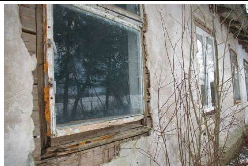
Būve (dzīvojamā ēka) ar kadastra apzīmējumu 6488 006 0037 007
