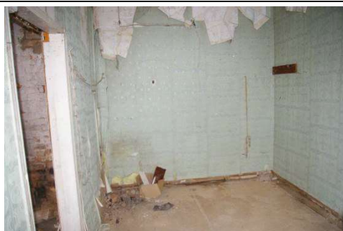
Būve (dzīvojamā ēka) ar kadastra apzīmējumu 6488 006 0037 007
