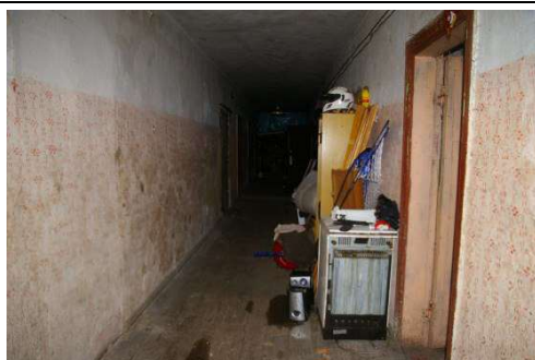
Būve (dzīvojamā ēka) ar kadastra apzīmējumu 6488 006 0037 007
