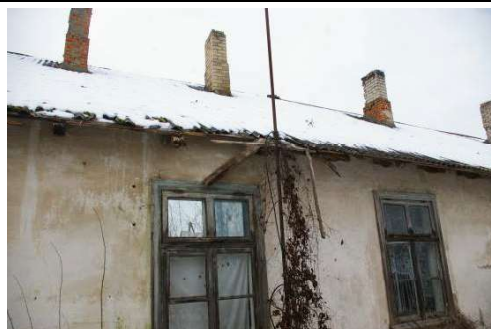
Būve (dzīvojamā ēka) ar kadastra apzīmējumu 6488 006 0037 007
