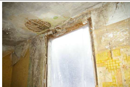
Būve (dzīvojamā ēka) ar kadastra apzīmējumu 6488 006 0037 007
