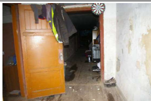
Būve (dzīvojamā ēka) ar kadastra apzīmējumu 6488 006 0037 007
