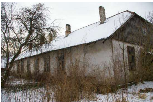
Būve (dzīvojamā ēka) ar kadastra apzīmējumu 6488 006 0037 007
