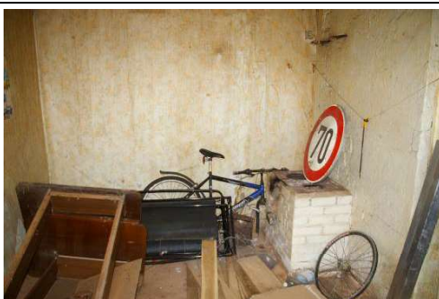
Būve (dzīvojamā ēka) ar kadastra apzīmējumu 6488 006 0037 007
