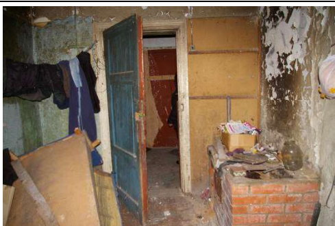
Būve (dzīvojamā ēka) ar kadastra apzīmējumu 6488 006 0037 007
