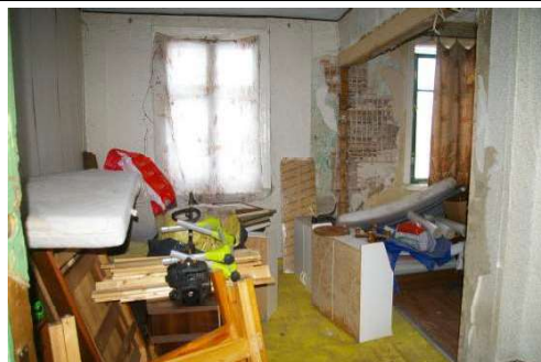
Būve (dzīvojamā ēka) ar kadastra apzīmējumu 6488 006 0037 007
