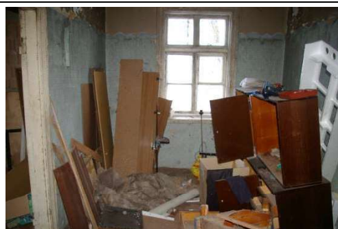
Būve (dzīvojamā ēka) ar kadastra apzīmējumu 6488 006 0037 007
