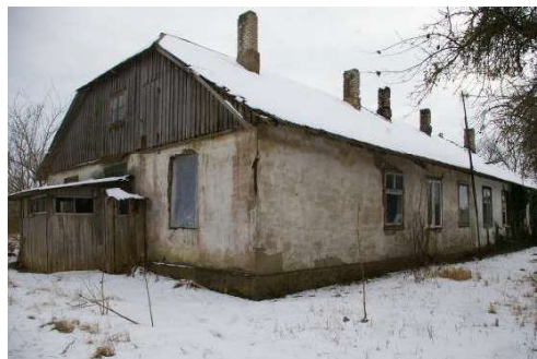
Būve (dzīvojamā ēka) ar kadastra apzīmējumu 6488 006 0037 007
