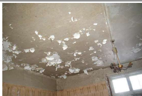
Būve (dzīvojamā ēka) ar kadastra apzīmējumu 6488 006 0037 007
