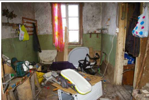
Būve (dzīvojamā ēka) ar kadastra apzīmējumu 6488 006 0037 007
