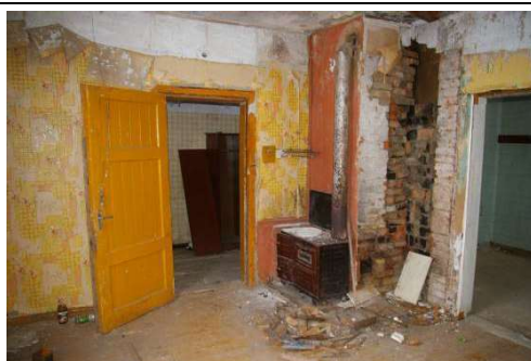
Būve (dzīvojamā ēka) ar kadastra apzīmējumu 6488 006 0037 007
