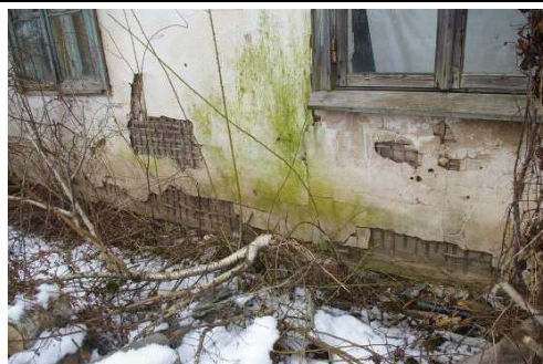
Būve (dzīvojamā ēka) ar kadastra apzīmējumu 6488 006 0037 007
