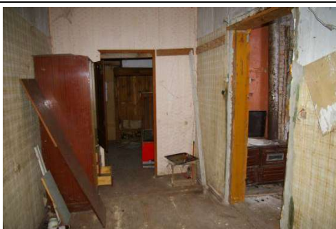
Būve (dzīvojamā ēka) ar kadastra apzīmējumu 6488 006 0037 007
