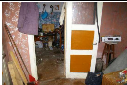
Būve (dzīvojamā ēka) ar kadastra apzīmējumu 6488 006 0037 007
