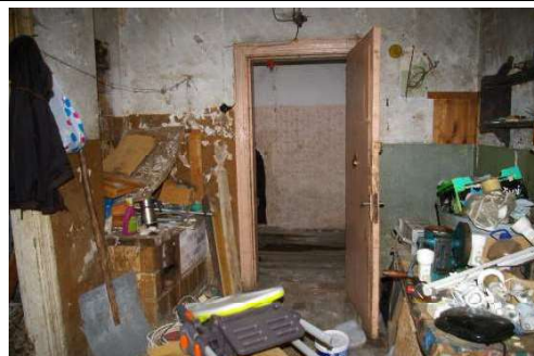
Būve (dzīvojamā ēka) ar kadastra apzīmējumu 6488 006 0037 007
