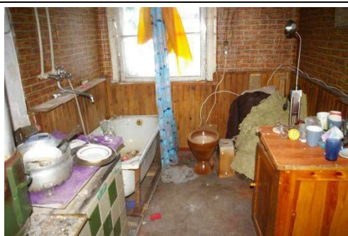
Būve (dzīvojamā ēka) ar kadastra apzīmējumu 6488 006 0037 007
