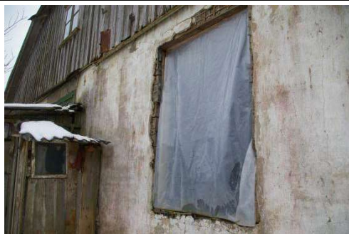
Būve (dzīvojamā ēka) ar kadastra apzīmējumu 6488 006 0037 007
