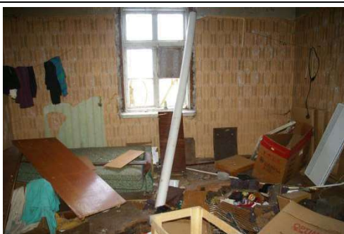
Būve (dzīvojamā ēka) ar kadastra apzīmējumu 6488 006 0037 007
