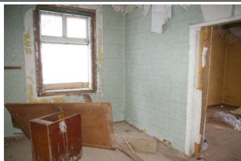
Būve (dzīvojamā ēka) ar kadastra apzīmējumu 6488 006 0037 007
