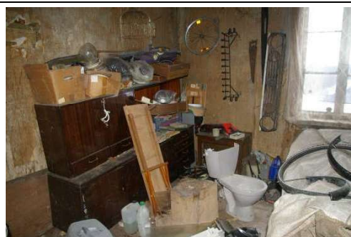
Būve (dzīvojamā ēka) ar kadastra apzīmējumu 6488 006 0037 007
