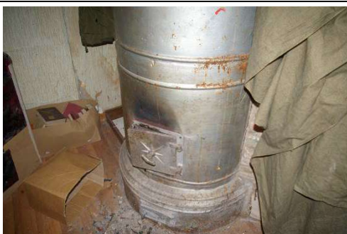
Būve (dzīvojamā ēka) ar kadastra apzīmējumu 6488 006 0037 007, krāsns
