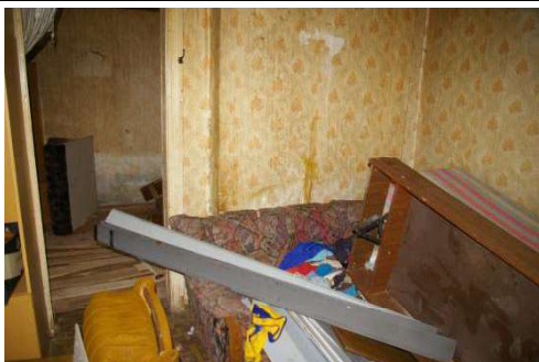
Būve (dzīvojamā ēka) ar kadastra apzīmējumu 6488 006 0037 007
