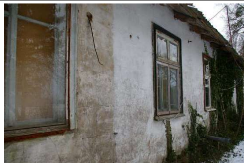
Būve (dzīvojamā ēka) ar kadastra apzīmējumu 6488 006 0037 007
