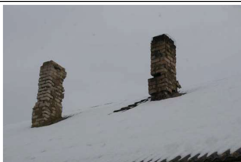
Būve (dzīvojamā ēka) ar kadastra apzīmējumu 6488 006 0037 007, dūmvadi
