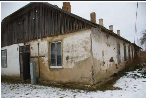
Būve (dzīvojamā ēka) ar kadastra apzīmējumu 6488 006 0037 007
