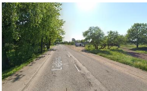
4-26. ATTĒLS. SKATS UZ LIELĀS IELAS POSMU STARP VENTSPILS UN BĀRTAS IELĀM
