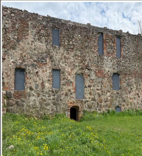
Austrumu korpusa būves daļas ailu pārsedzes.
