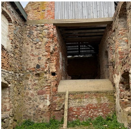
Dienvidu korpusa austrumu siena.
