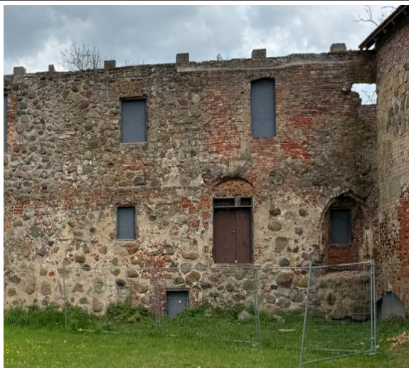
Austrumu korpusa būves daļas ailu pārsedzes.
