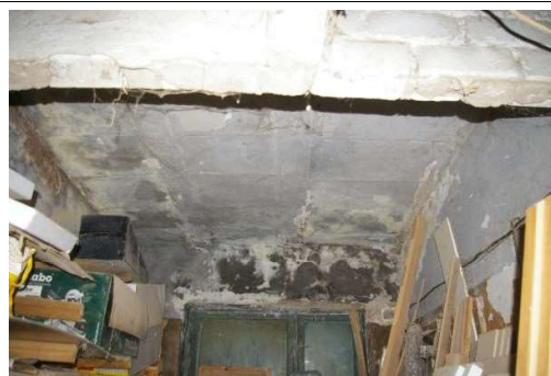
Būve (katlu mājas ēka) ar kadastra apzīmējumu 6427 002 0244 001
