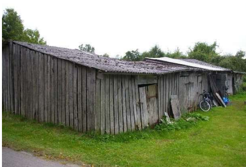
Durbes pilsētas zemesgrāmatas nodaļā Nr.100000955360 neregistrēta Būve (šķūņa ēka) ar kadastra apzīmējumu 6427 002 0244 005
