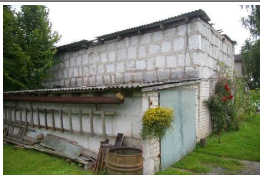
Būve (katlu mājas ēka) ar kadastra apzīmējumu 6427 002 0244 001
