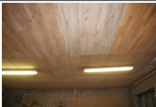
Būve (katlu mājas ēka) ar kadastra apzīmējumu 6427 002 0244 001
