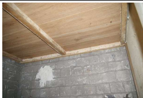
Būve (katlu mājas ēka) ar kadastra apzīmējumu 6427 002 0244 001
