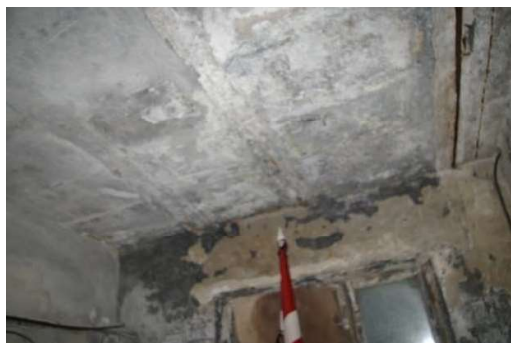
Būve (katlu mājas ēka) ar kadastra apzīmējumu 6427 002 0244 001
