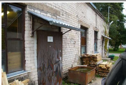
Būve (katlu mājas ēka) ar kadastra apzīmējumu 6427 002 0244 001
