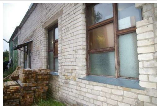
Būve (katlu mājas ēka) ar kadastra apzīmējumu 6427 002 0244 001
