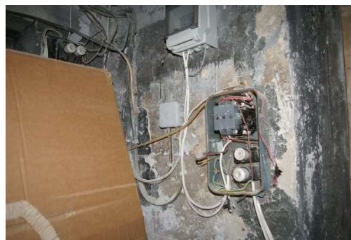
Būve (katlu mājas ēka) ar kadastra apzīmējumu 6427 002 0244 001
