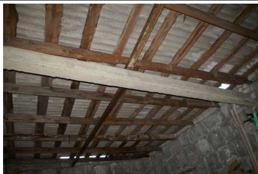
Būve (katlu mājas ēka) ar kadastra apzīmējumu 6427 002 0244 001
