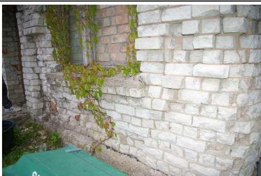
Būve (katlu mājas ēka) ar kadastra apzīmējumu 6427 002 0244 001
