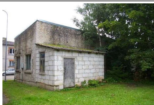
Būve (katlu mājas ēka) ar kadastra apzīmējumu 6427 002 0244 001
