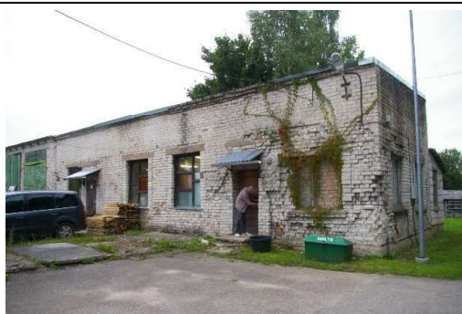
Būve (katlu mājas ēka) ar kadastra apzīmējumu 6427 002 0244 001
