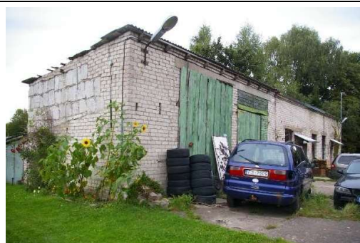
Būve (katlu mājas ēka) ar kadastra apzīmējumu 6427 002 0244 001
