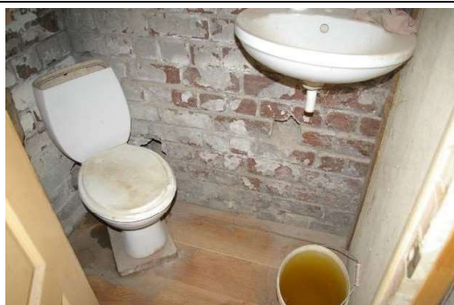
Būve (katlu mājas ēka) ar kadastra apzīmējumu 6427 002 0244 001
