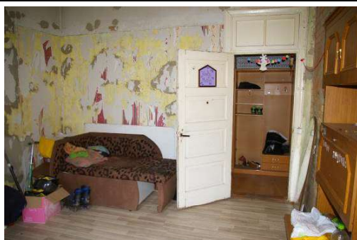
Būve ar kadastra apzīmējumu 6442 001 0026 001, dzīvoklis Nr.5, telpa Nr.7
