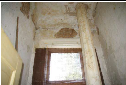
Būve ar kadastra apzīmējumu 6442 001 0026 001, dzīvoklis Nr.5, telpa Nr.4
