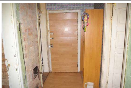
Būve ar kadastra apzīmējumu 6442 001 0026 001, dzīvoklis Nr.5, telpa Nr.1
