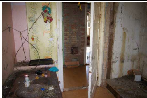
Būve ar kadastra apzīmējumu 6442 001 0026 001, dzīvoklis Nr.5, telpa Nr.2
