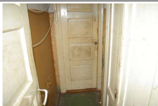
Būve ar kadastra apzīmējumu 6442 001 0026 001, dzīvoklis Nr.5, telpa Nr.5
