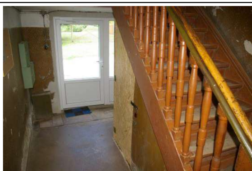
Būve ar kadastra apzīmējumu 6442 001 0026 001, koplietošanas telpa
