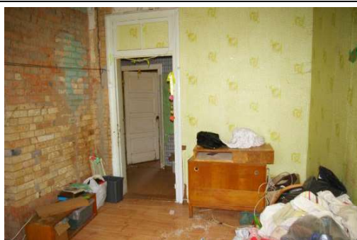
Būve ar kadastra apzīmējumu 6442 001 0026 001, dzīvoklis Nr.5, telpa Nr.6
